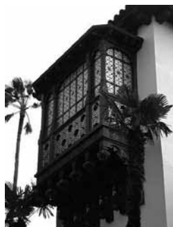
Janela de sacada fechada
