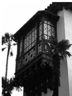
Janela de sacada fechada
